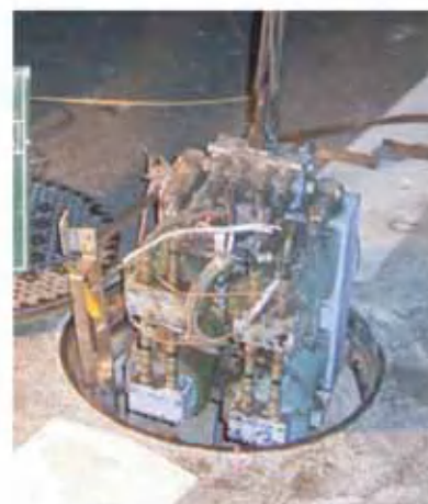
マンホールより削進機吊込み状況
