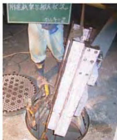
マンホールより架台吊込み状況
