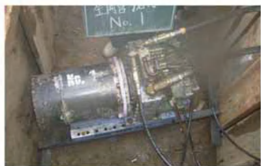
開削溝設置状況
