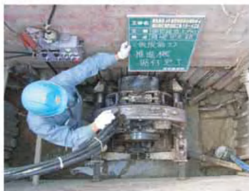
開削溝 推進機据付完了
