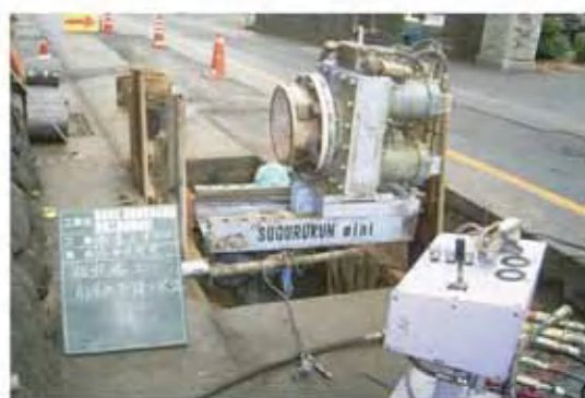
削進機吊込み状況
