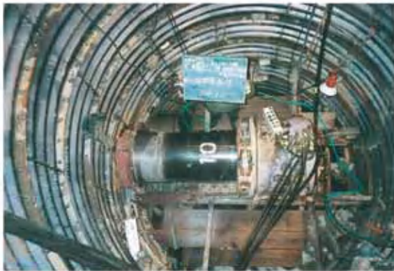
鋼管径 \phi 650 据付状況
