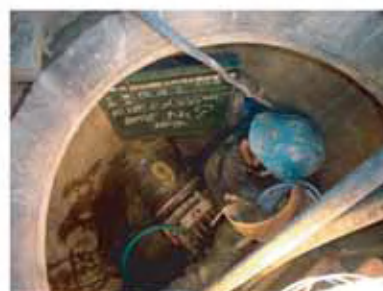
1号人孔 管推進状況
