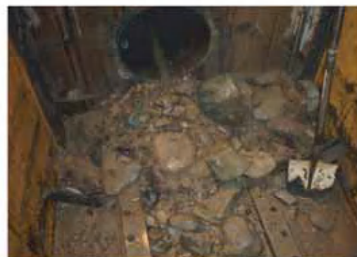
転石排土状況
