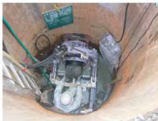
岩盤削進状況
