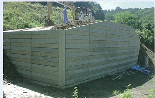
【試験施工状況】
