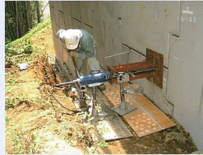
【幅広ストリップの引抜き試験状況】
