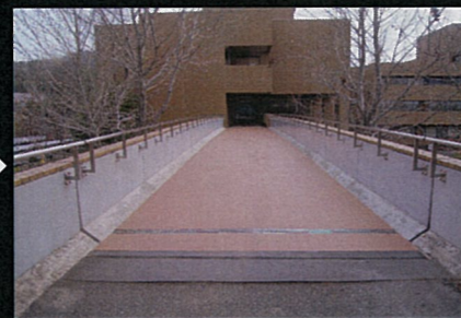
東広島市・広島大学構内
