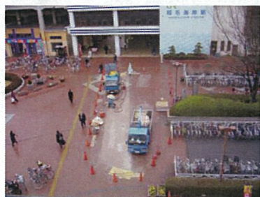
住宅街や街中でも安全な施工力
