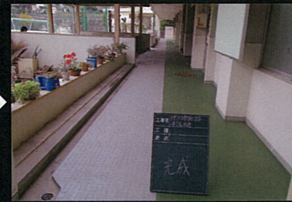
安芸区・中野小学校廊下
