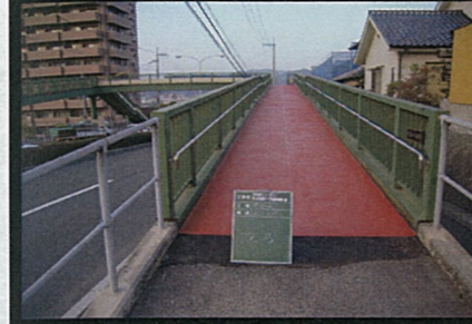
安芸区・歩道橋橋面補修
