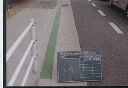
安佐南区・歩車道境界ブロック
