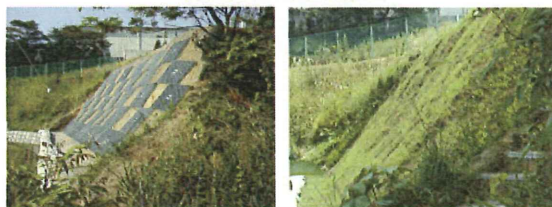
5分勾配 施工後1ヶ月 グリーンパネル工法によるのり面補強 従来工法とグリーンパネル工法の施工例
