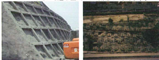
従来工法によるのり面補強
