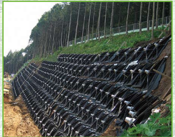
※ 逆巻き施工が可能で安全に作業できます。
